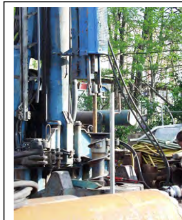
Abb. 2: Systemeinsatz in eine laufende Bohrung
